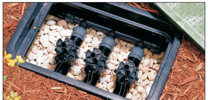
studzienka irygacyjna z elektrozaworami
