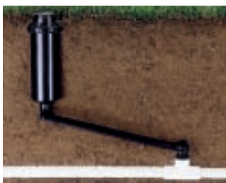
Typowa instalacja ze złączem obrotowym.
